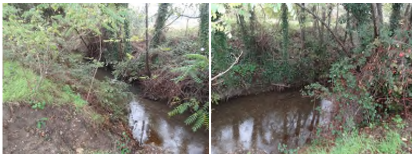
Photo 4 – Vues du canal affecté par la traversée du réseau d'adduction
